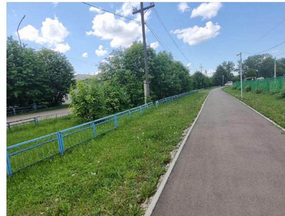
3. Высокорослая растительность пересекается с ЛЭП
